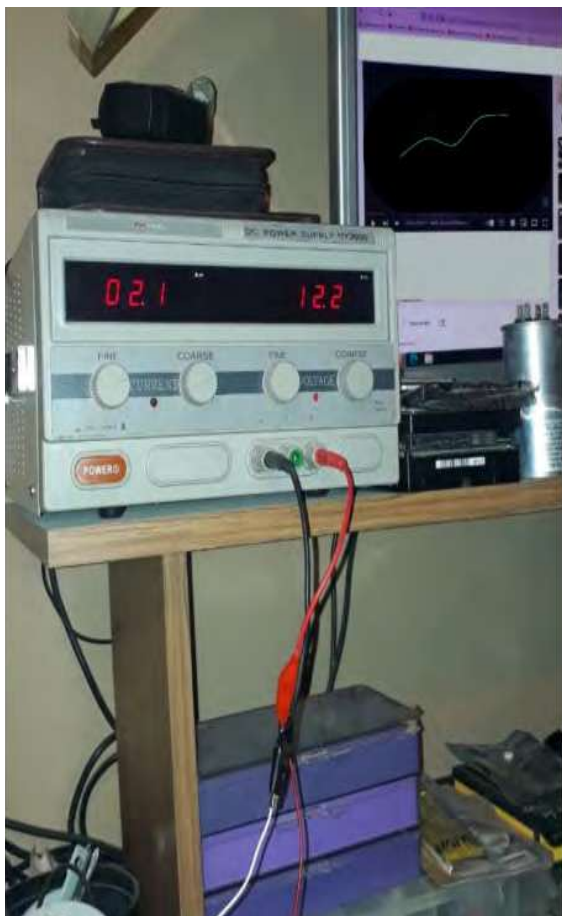
Figura 5: Tensión y Corriente de Trabajo del Gabinete
