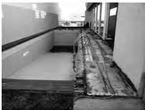
Fig.8. Levantamiento del deck en la zona de pileta para detectar fisuras, fugas o posibles roturas.
